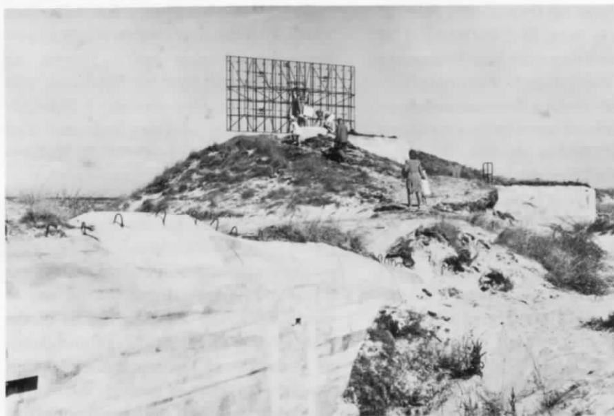
Marineradar-anlæg på Grenen. Radarbunker i baggrunden og mandskabsbunker i forgrunden; mandskabsbunkeren med den karakteristiske ringstilling på taget.
