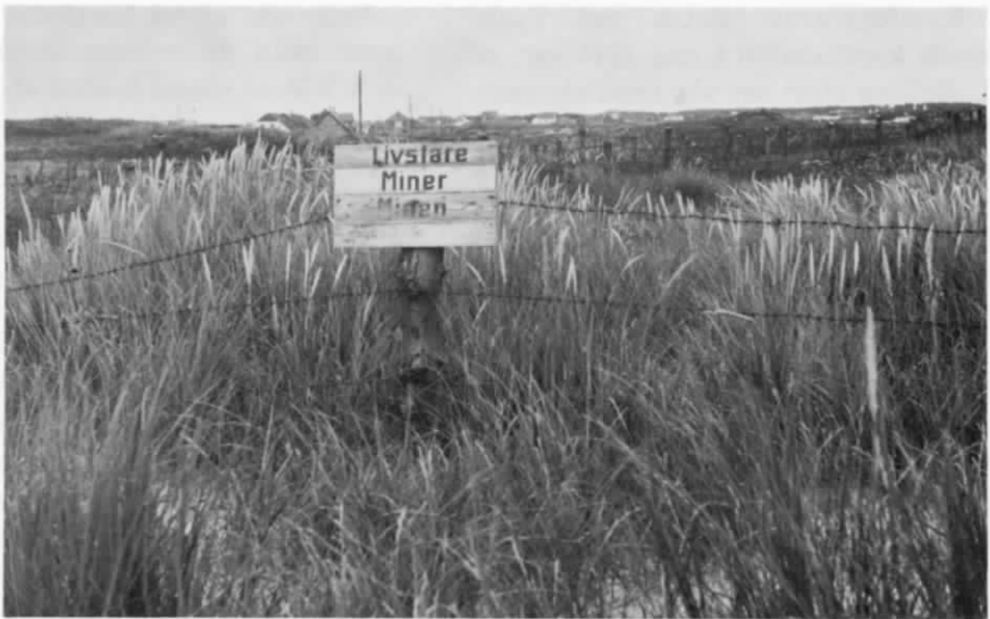
Rundt om de befæstede byer lå der store pigtråds- og minespærringer, pansergrave m.v. Indbyggerne var i praksis spærret inde. Her Blokhus.
