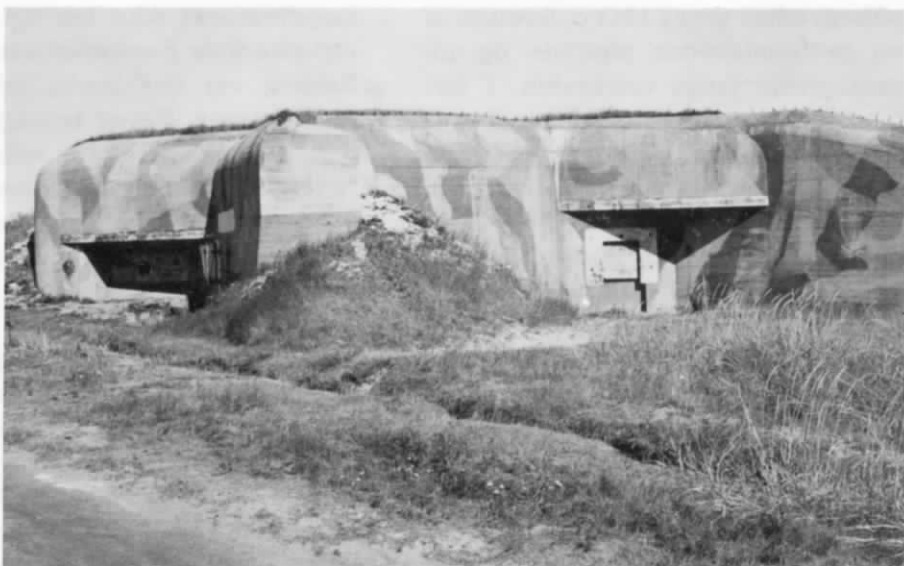
Svær bunker til panserværnskanon ved Skagen. Sløringsnettene er fjernet, men bunkeren er endnu camouflagemalet. Man aner her anlæggenes kraftige dimensioner.
