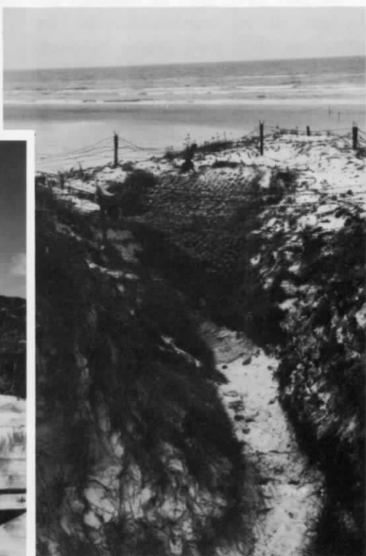
Velsløret bunker i forreste klitrække ved Løkken. Her ses også en af de karakteristiske løbegrave frem til anlægget.
