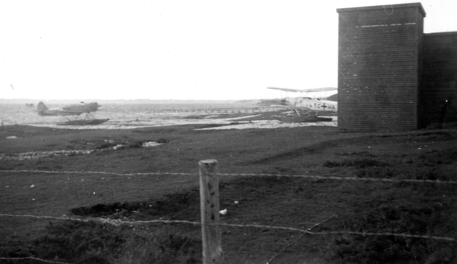
Skinflyvepladsen ved Fårtoft øst for Thisted. I forgrunden ses en stor "hangar" - man aner, at den er fremstillet af tynde lister - og i bag- grunden udrangerede søfly. (Museumscenter Hanstholm)
