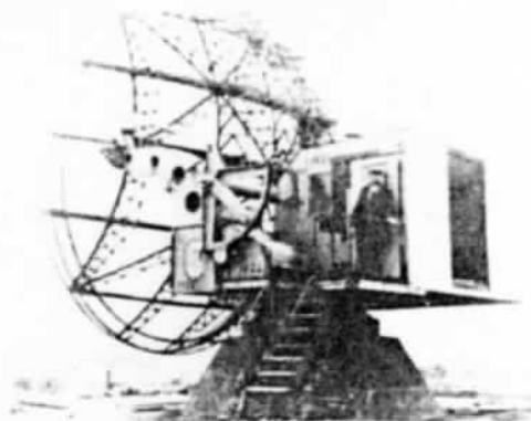
Fotografi af et af radaranlæggene i yderste klitrække i »Ringelnatter«. Radaren er en »Würzburg Riese«, og der var to af denne type med ca. 100 meters afstand. Fundamenterne findes let i dag.
