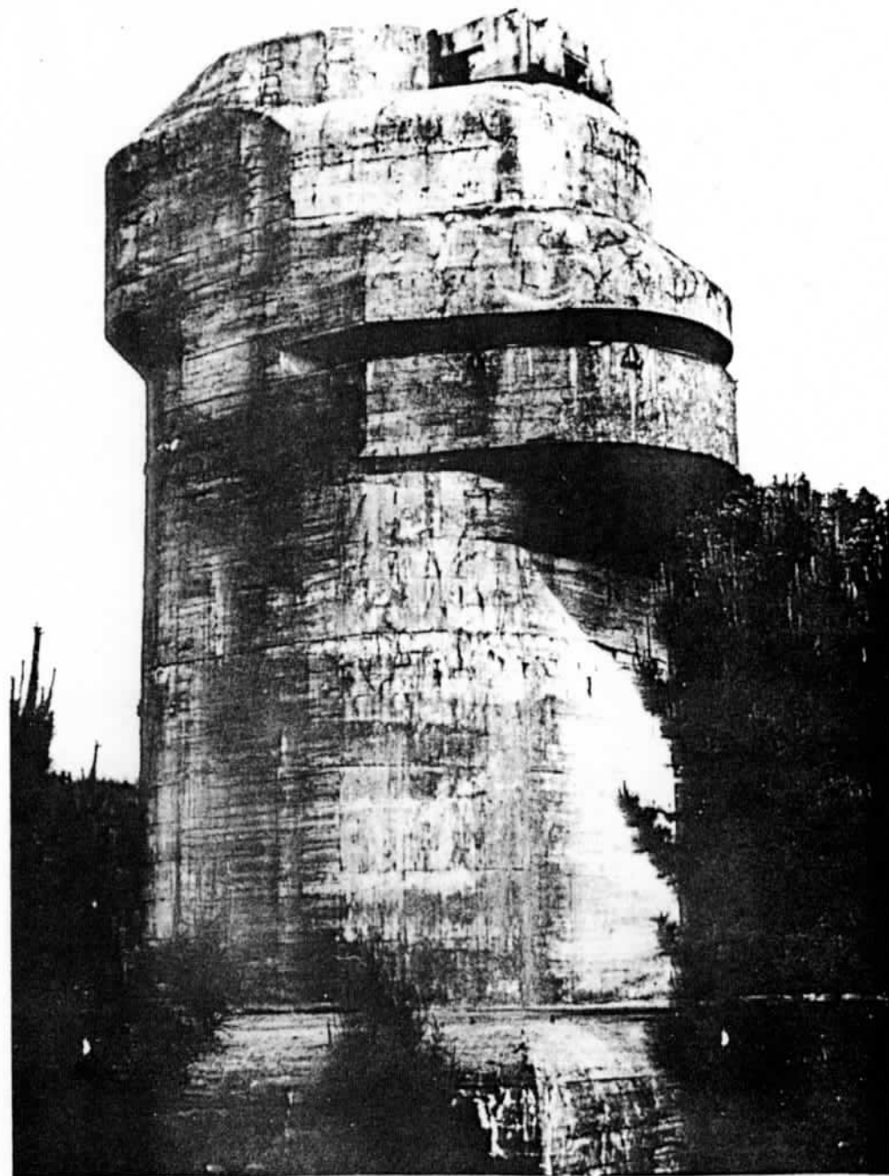
Skitse 1. Leitstand af typen Regelbau S 497. Dette observations- og ildledertårn skulle betjene et marinekystbatteri med fire 20,3 cm kanoner, »KAROLA«, ved la Rochelle (den franske Atlanterhavskyst). En lignende Leitstand skulle have været opført ved TIRPITZ og ved det planlagte batteri på Læsø. Ved TIRPITZ var det tanken at opstille radarer af typen Würzburg - Reise som supplement til observationer m.m. fra Leitstand. (Rudi Rolf).
