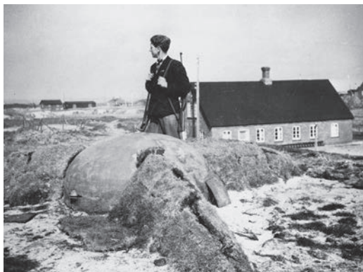
Panserkuppel i observationsbunkeren (Regelbau 666) i diget ved signalmasten. Græstørvene tjener til at sløre kuplens kontur, men er lagt i tre "streng", så de ikke dækker observationsåbningerne i tårnets side. Der var desuden et hul i toppen af kuplen til et periskop. (Lokalhistorisk Arkiv for Thisted Kommune, 4610).
