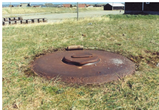
Panserkuplen i bunkeren til en 5 cm maskinmortér, som ligger ved Vandbygningsvæsenets gamle baneterræn. I 2000 viste det sig, at mortéren stadig stod på sin plads i bunkeren. Den blev derfor bjerget af Besættelsestidshistorisk Selskab for Thy og Vester Hanherred, og den kan i dag beses i restaureret stand i Museumscenter Hanstholm. (Jens Andersen, 1990).
