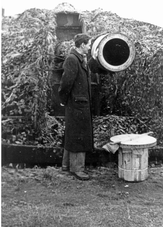
En dansk civilist stående foran et 38 cm-kanontårn dækket med camouflagenet. Man får her et godt indtryk af kanonrørets dimensioner. På jorden under kanoner står mundingsproppen, som beskyttede løbets indre mod vind og vejr. (Bunkermuseum Hanstholm).
