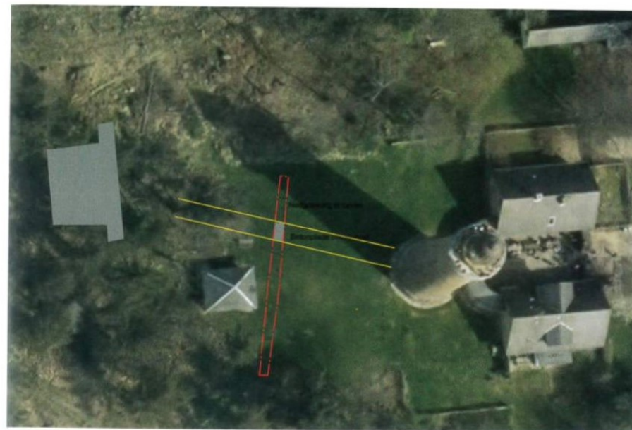
Luftfoto af Lodbjerg Fyr med indtegning af den arkæologiske prøvegravt fra juni 2018 (rød), tunnelens forløb (gul) samt bunkeren (grå). Museum Thy.
