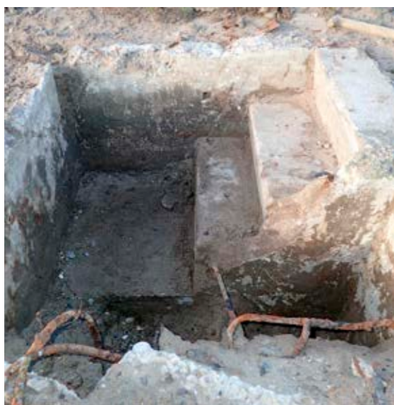
Nordenden af den nedbrudte betonbygning nord for udhuset. Man ser trapperne, som førte ned i rummet. Bunkermuseum Hanstholm.
