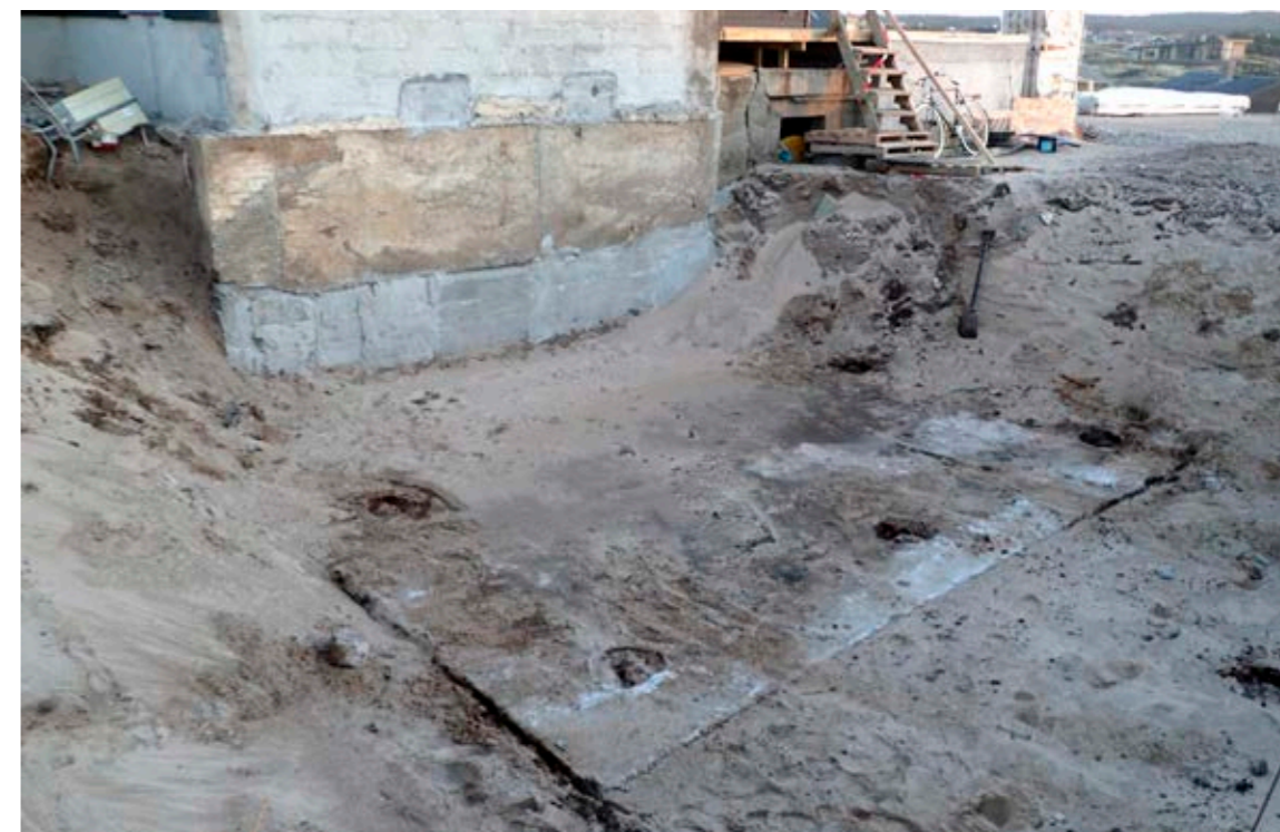
Fundamentspladen, som blev afdækket i forbindelse med udgravningen af fundamentet til det nye »Udsigten«. Den østligste del af fundamentetspladen var dækket af fundamentet under den nye udgave af »Tårnet« og kunne derfor kun dokumenteres delvist. Bunkermuseum Hanstholm.
