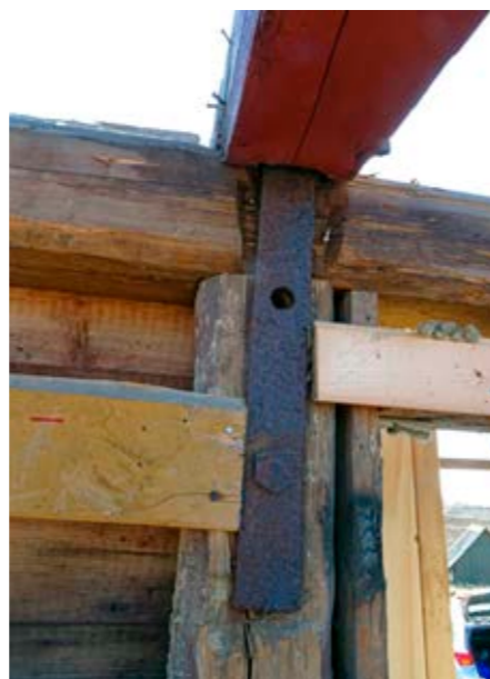
»Tårnet«s sydvæg med det smedejernsbeslag, som fæstnede spærret til stolpen. Beslaget var ført igennem spærret og fastgjort med en bolt i enden.
